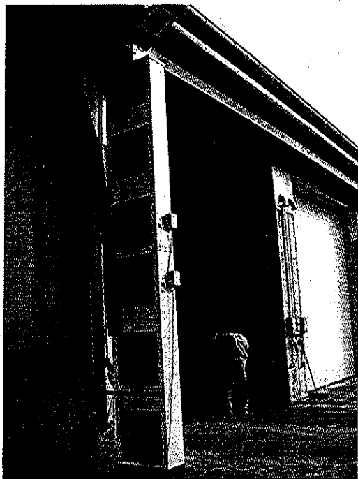
Abb. 4.1.2.7 Nach- Behandlungsanlage Geöffnetes Rolltor Luftwandanlage
