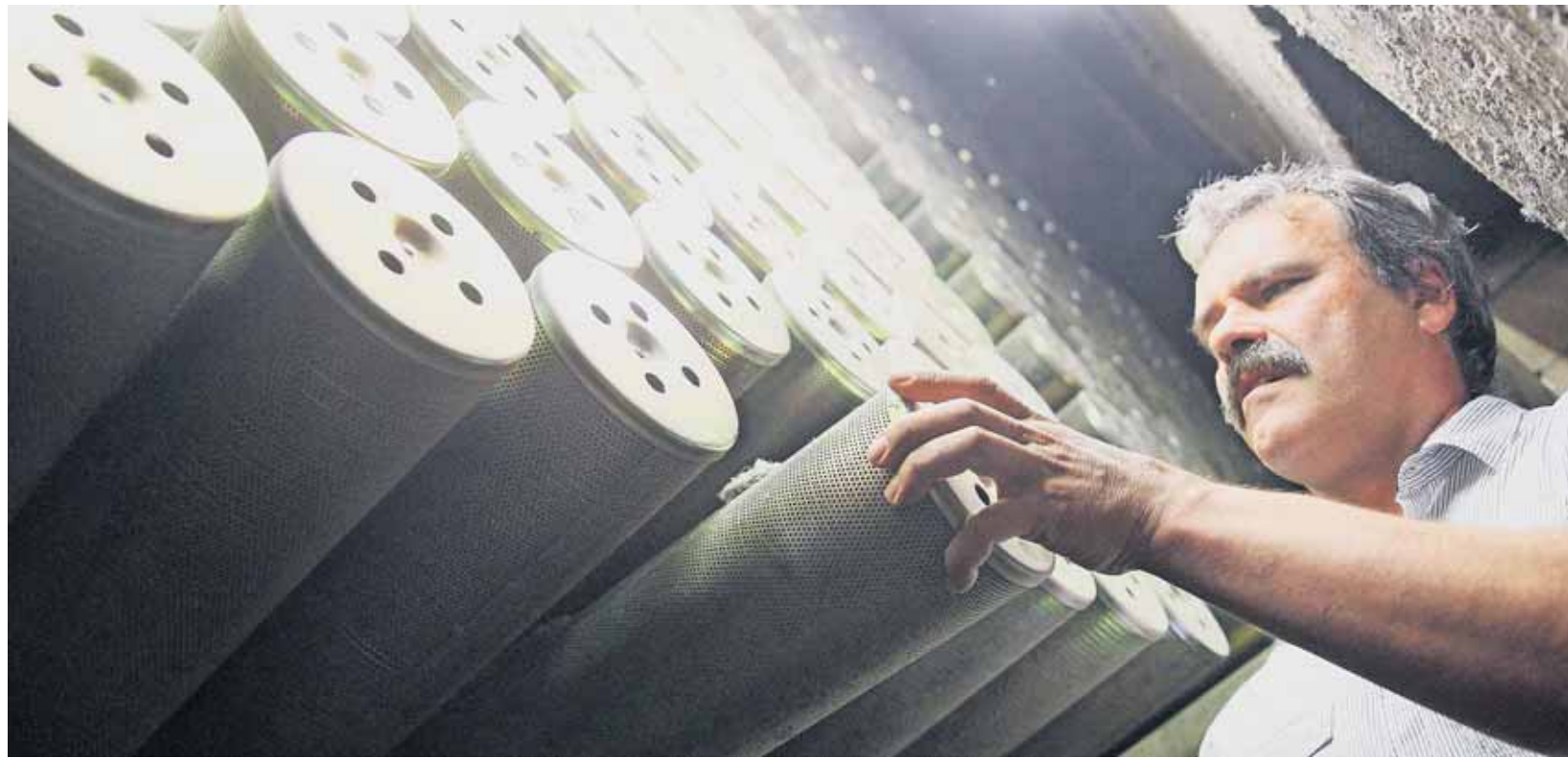
Mitte August sind Aktivkohlefilter von Ingenieur Frank Riedel (Bild) und seinen Mitarbeitern in den Abluftkamin des Recyclingbetriebs Eu-Rec installiert worden. TV-FOTO: ARCHIV/FRIEDEMANN VETTER
